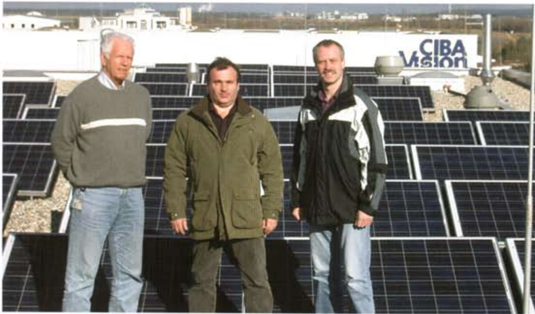
Jan Kohoutek (Leiter Site Security), Kurt Schwab (Elektromeister) und der Leiter Site Services, Rainer Bott, sorgen für das reibungslose Funktionieren der Solaranlage von CIBA VISION.
